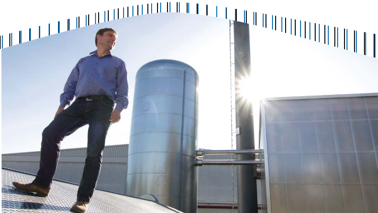
Daniel Weiß vor dem Holzhackschnitzel-Heizkraftwerk im Nahwärmenetz Steinen
