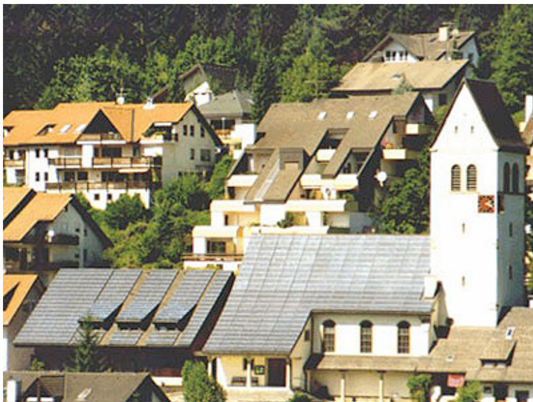
Schönauer Bergkirche und Gemeindehaus mit Gemeinschaftsphotovoltaikanlage Fotos: EWS
